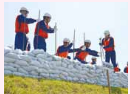
土のう積み工法を行う水防団
