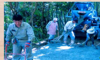
（コンクリート舗装）
