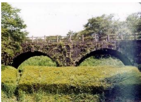
写真 移築復元された湯町橋
