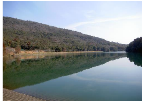
写真 湯の口ため池
