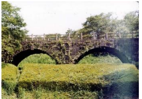
写真 移築復元された湯町橋
