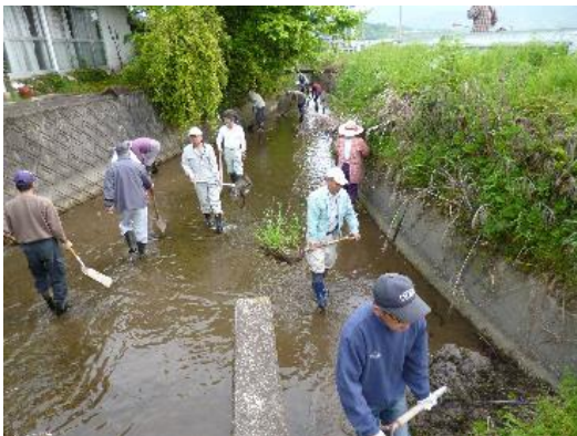
写真 水路の浚渫の様子
