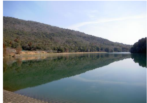
写真 湯の口ため池
