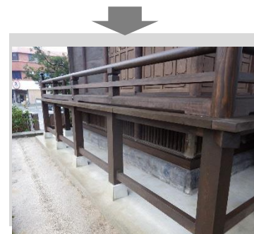
薬師堂の修理後
