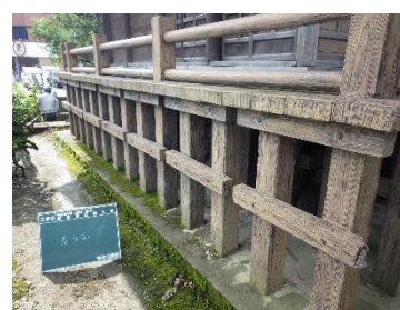
薬師堂の修理前
