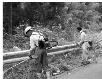
山鹿地区(右上) 鹿央地区(左上) 菊鹿地区(左下)での作業の様子
