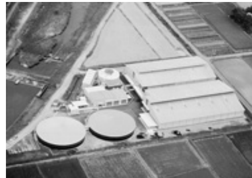
鹿本町高橋に完成したバイオマスセンター
