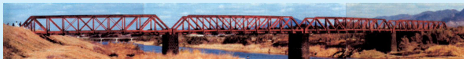
▲分田付近の菊池川に架かっていた鉄橋の全景（本山幸嘉氏撮影）
