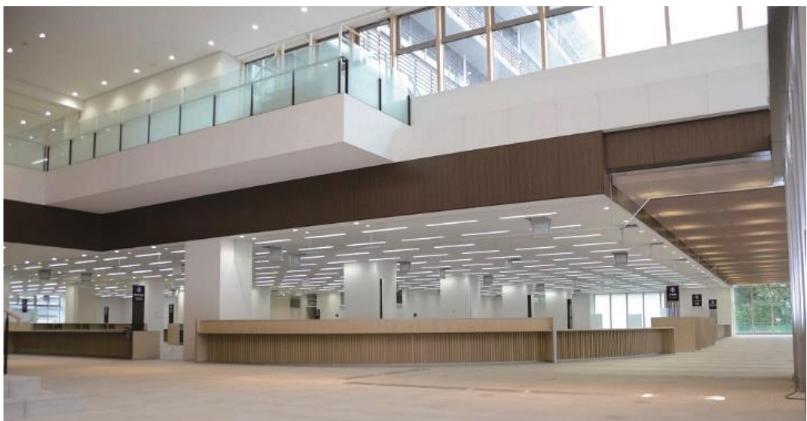
■ 市役所内部（LED 照明の設置）
