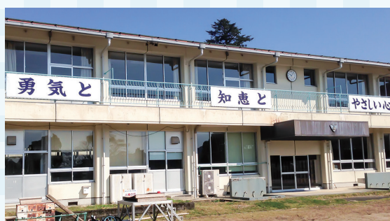
和水農場事務所(旧緑小学校)
