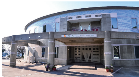
本社(熊本県益城町)
