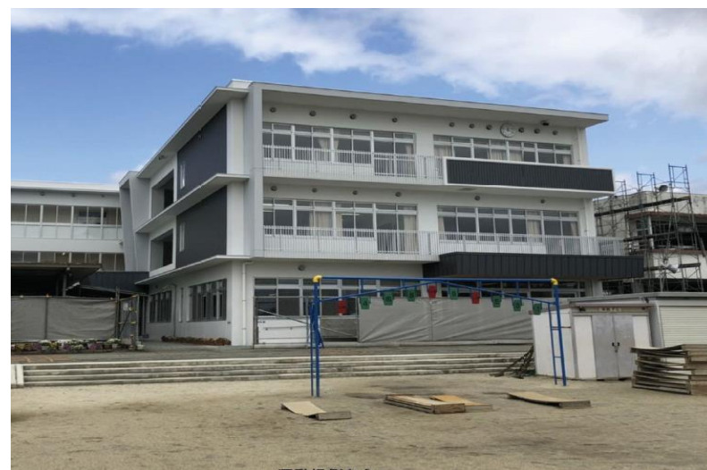
鹿本小学校建築状況
